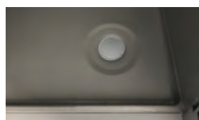
Bonde d'évacuation des eaux de nettoyage
